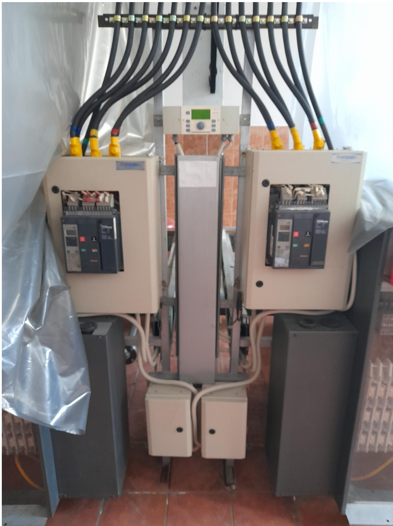
Fig. 2 Conexiuni Centrala termica CHE Ciunget
